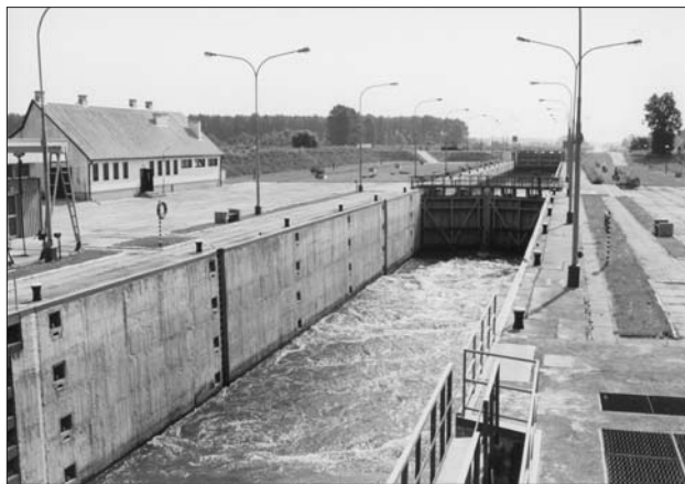
Modernizovaná plavební komora Zwanowice na Odře má již rozměry 190 x 12 m a odpovídá tedy třídě Vb.
