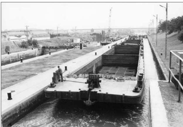
Proplavování tlačné soupravy velkou plavební komorou Rogów na Odře. Komora je téměř 190 m dlouhá, má však nedostatečně široká ohlavi (jen 9,6 m), takže je překážkou přechodu na standardní plavidla, podobně jako většina komor ostatních.
