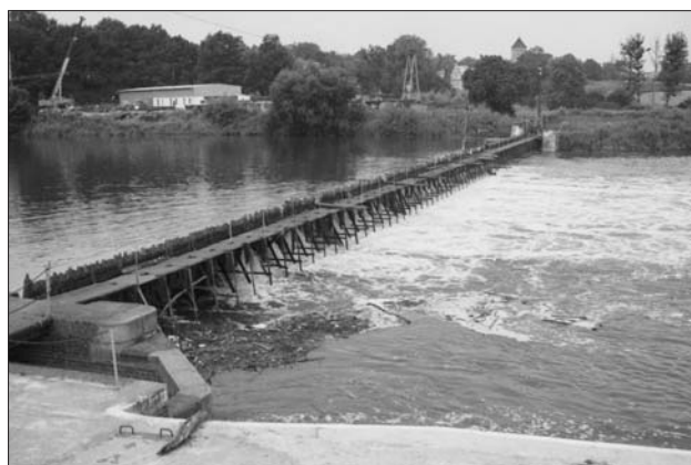
Typický hradlový jez na Odře (jez Rogów - dnes již nahrazený moderní konstrukcí). Takové jezy - dnes již plavebním požadavkům zdaleka neodpovídající - zůstávají na Odře již jen dva.
