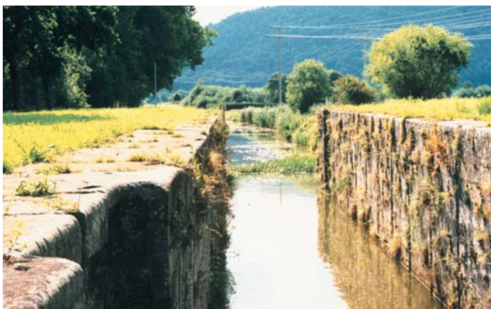
Zbytky plavební komory z dob slávy Ludvíkova průplavu
