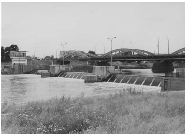
Nové oderské jezy jsou zpravidla sektorového typu, jak ukazuje příklad z Wrocławí.
