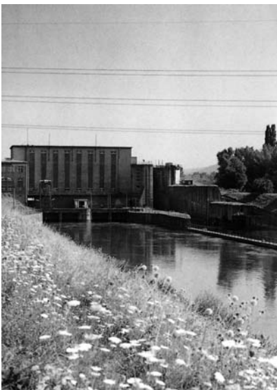
Stupeň Horná Streda s čiastočne vybudovanou plavebnou komorou
