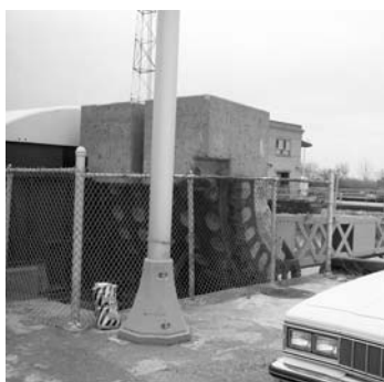
Rameno dynamické ochrany je vyváženo betonovým protizávažím
