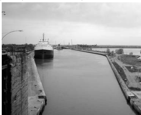
Horní rejsa plavební komory na průplavu Welland
