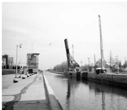
Horní ohlaví plavební komory průplavu Welland je opatřeno dynamickou ochranou, zvedacím mostem a velínem
