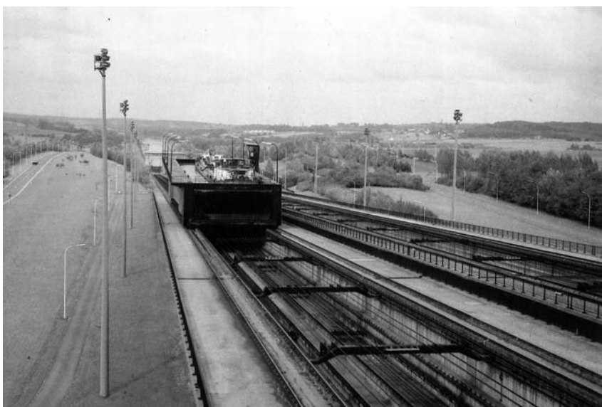
Šikmé lodní zdvihadlo Ronquières. Každý žlab s užitečnými rozměry 90 x 12 x 3,7 m pojíždí po čtyřech kolejnicích, podvozek má 236 kol na 59 nápravách. Zdvihadlo překonává spád 67,55 m. Dokončeno bylo v roce 1968
