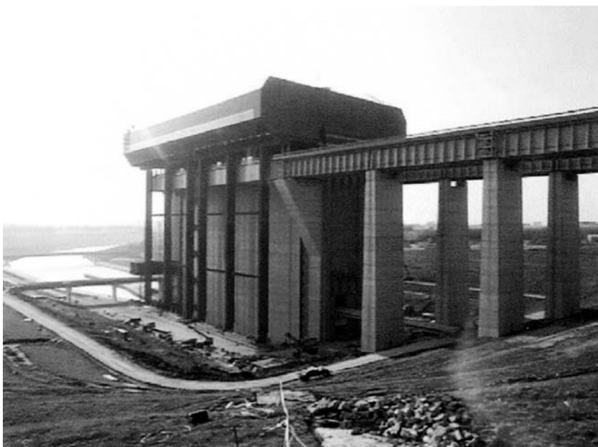
Pohled na akvadukt, zdvihadlo a dolní plavební kanál
