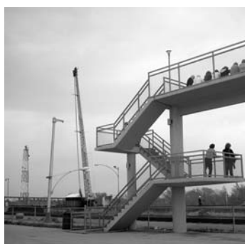
Vyhlídkové plošiny pro návštěvníky plavebních komor na vodní cestě sv. Vavřínce
