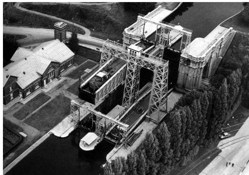
Pístové lodní zdvihadlo Bracquequies na průplavu Du Centre (zdvih 16,9 m, lodě 300 – 360 tun)
