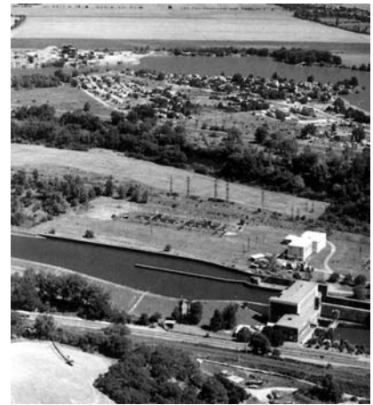
Plavebný stupeň Nové Mesto nad Váhom s čiastočne vybudovanou plavebnou komorou
