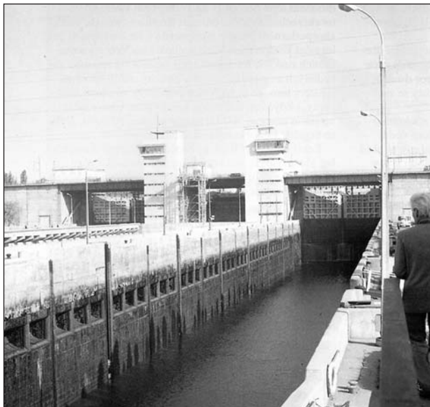
Dvojité dvoustupňové plavební komory vodního díla Volgograd na Volze.
