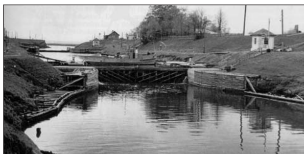
Typická stará plavební komora s přirozenými svahy a dřevěnými vzpěrnými vraty – Andrejevka na řece Moskvě.
