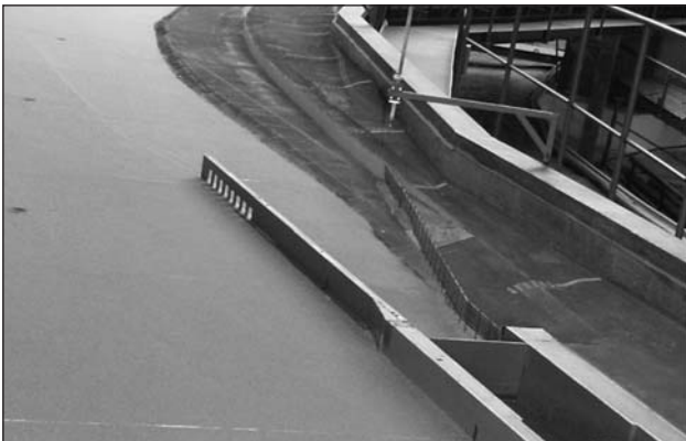
Obr. 6 - dělicí zeď horní rejdý plavební komory Prostřední Žleb
