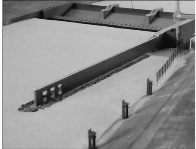
Obr. 7 - dělicí zeď dolní rejdý plavební komory Prostřední Žleb
