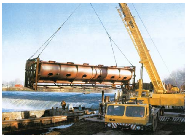
Instalace „balené“ jezové klapky na jezu Veletov na Labi v roce 1975
