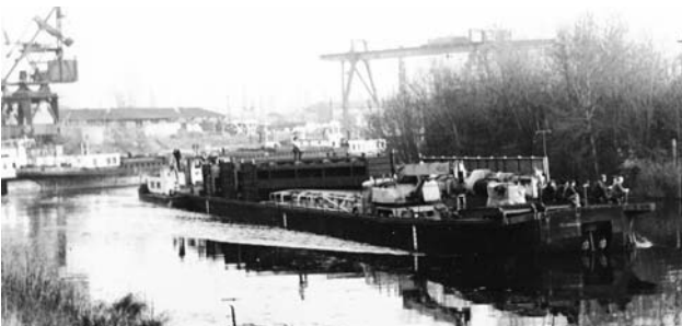
Nosná loď pro náhradní vrata plavební komory
