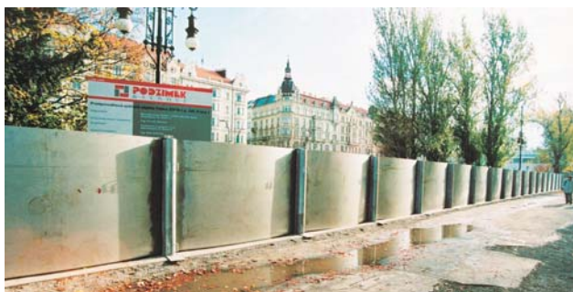
Protipovodňové mobilní hrazení membránového typu kolem paláce Žofín v Praze
