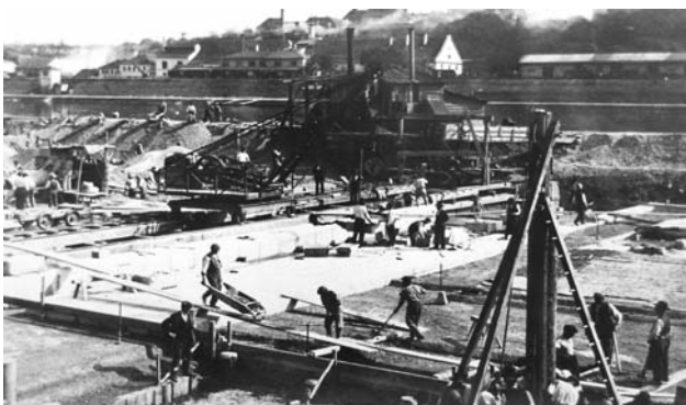
Výstavba mostu a jezu
