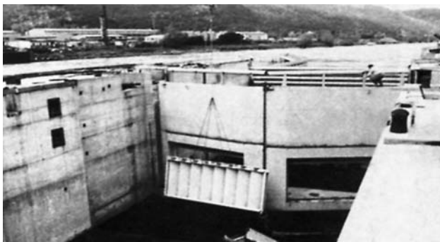
Montáž žaluziového uzávěru pro přímé prázdnění plavební komory v Praze-Modřanech
