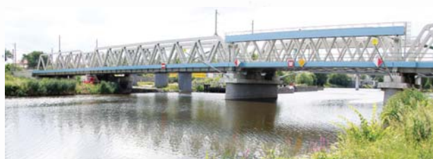
Nový železniční most v Kolíně
