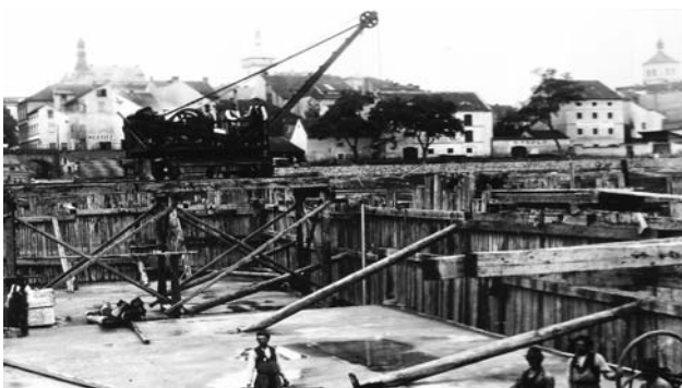
Betonáž silničního mostu
