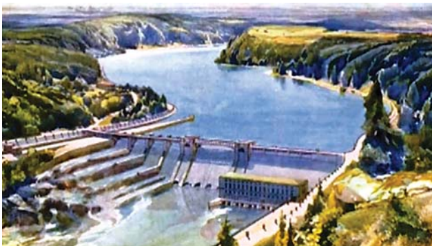
Návrh slapské přehrady od Ředitelství pro stavbu vodních cest z roku 1940 obsahoval i velkou plavební komoru
