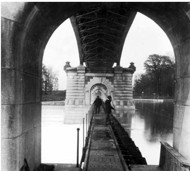
Dokončený hradlový jez pod mostovkou roudnického mostu
