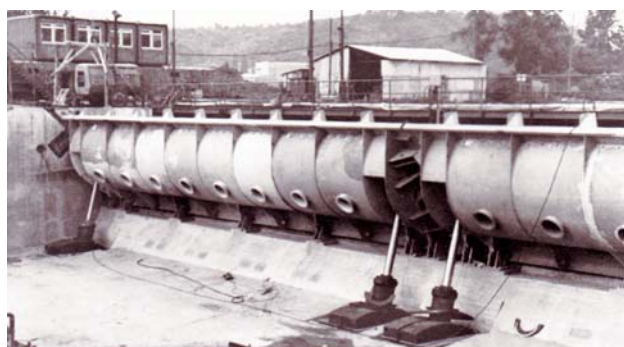
Pohled na ocelovou hradící konstrukci jezu Troja před uvedením do provozu
