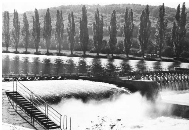
Ojedinelá vývojová konstrukce manipulačního pole na jezu Libčice, podle něhož byly zmodernizovány nebo postaveny všechny jezy na dolní Vltavě a některé na Labi a Ohří
