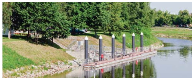
Přístaviště Lannova loděnice v Českých Budějovicích
