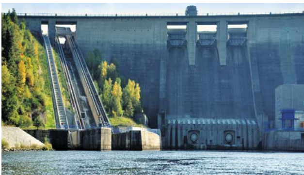
Šikmý lodní výtah pro sportovní lodě (vlevo) a nedokončený lodní výtah pro 300 tunové lodě na VD Orlik Foto: Emil Trokšiar
