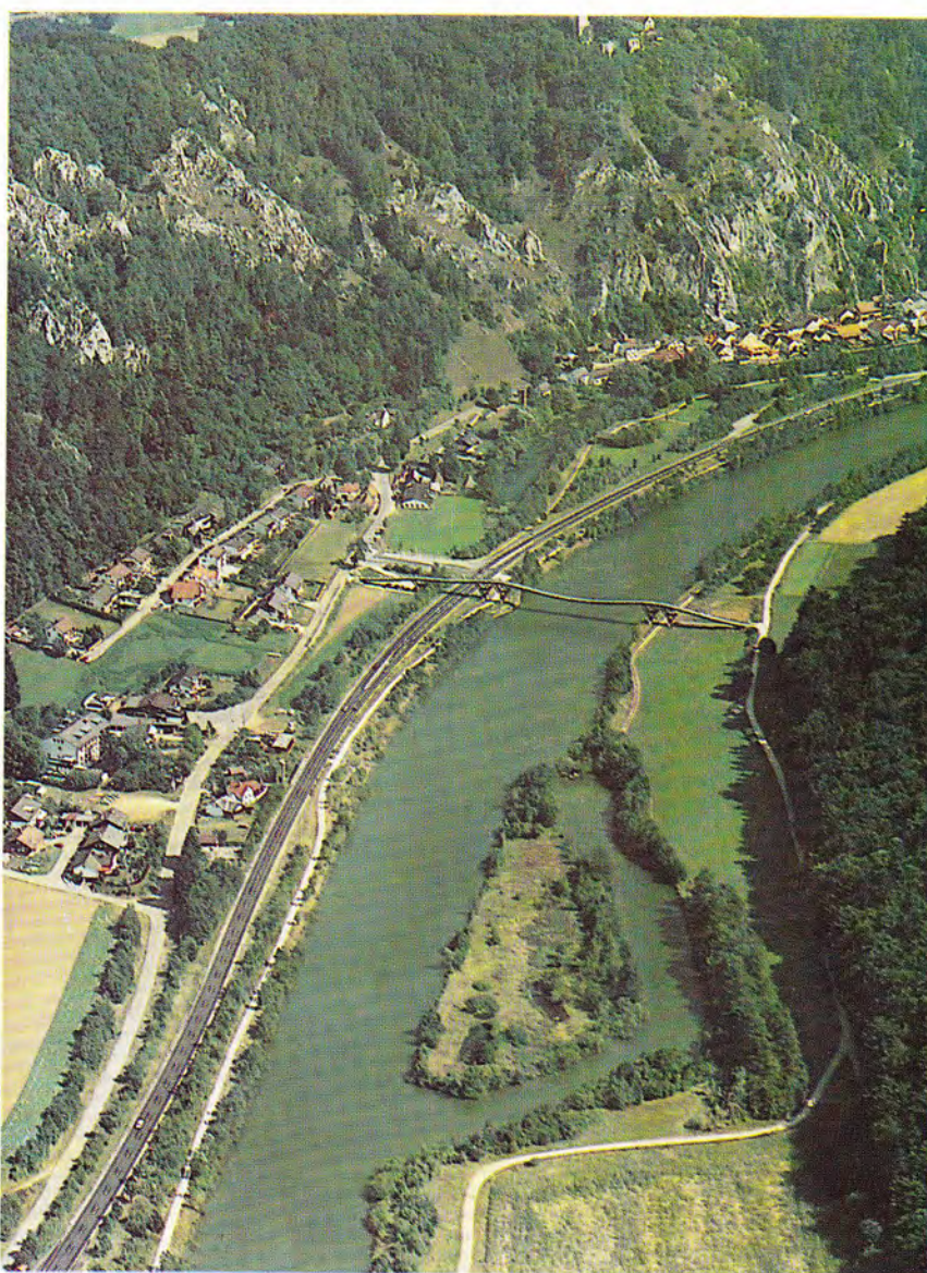
Bild 6. Ausgebaute Altmühl bei Neuessing
