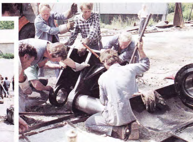
Kompletace ložisek klapkových vrat pro VD Gabčíkovo.
