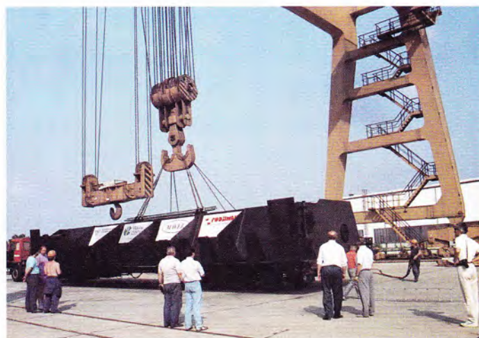
Přeprava klapkových vrat z Třeště a jejich vyložení pomocí 300t jeřábu v přístavu Bratislava.
