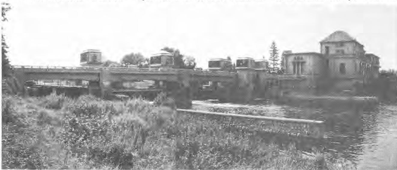
Jez Přelouč s mostem a vodní elektrárnou, v popředí téměř kompletně zanesená dolní rejsa s vyvinutou vegetací (foto P.Merta)
