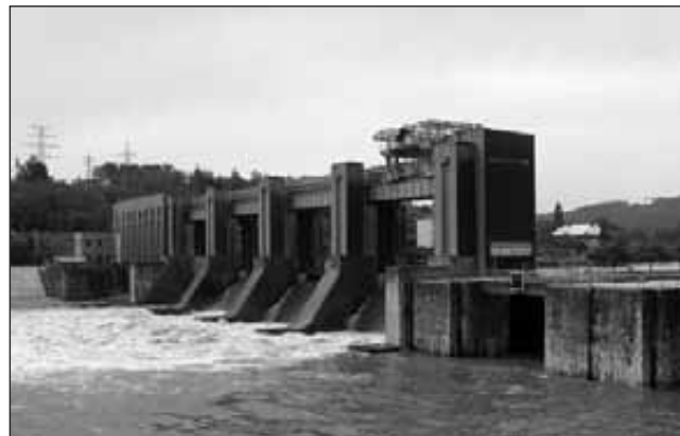
Vodní dílo Vrané nad Vltavou uvedené do provozu v roce 1936 T. G. Masarykem
