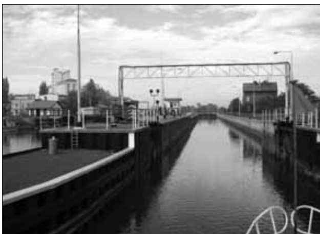
Plavební komora Brzeg
