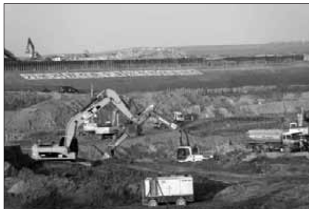
Hloubení základů pro plavební komoru na řece Han
