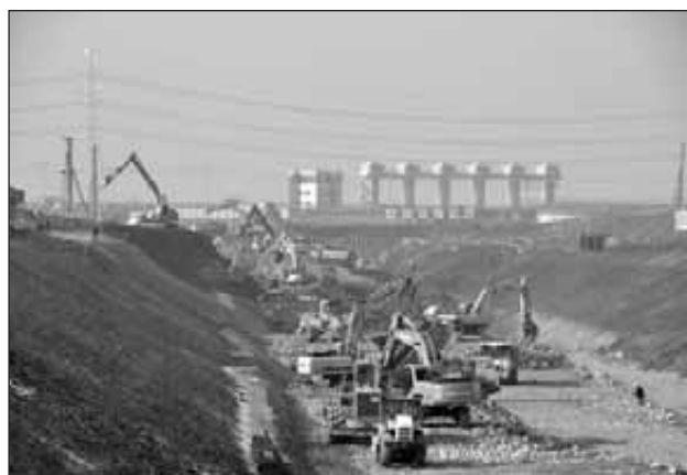
Výstavba průplavu v místě budoucího terminálu Incheon
