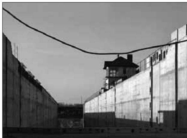
Plavební komora Malczyce ve výstavbě
