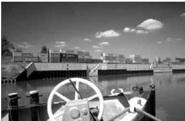
Mělník – rekonstrukce a modernizace přístavních zdí
