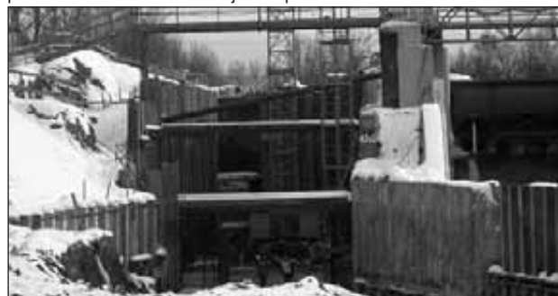
Výstavba plavební komory České Vrbné Foto Karel Stach, www.slalom.cz
