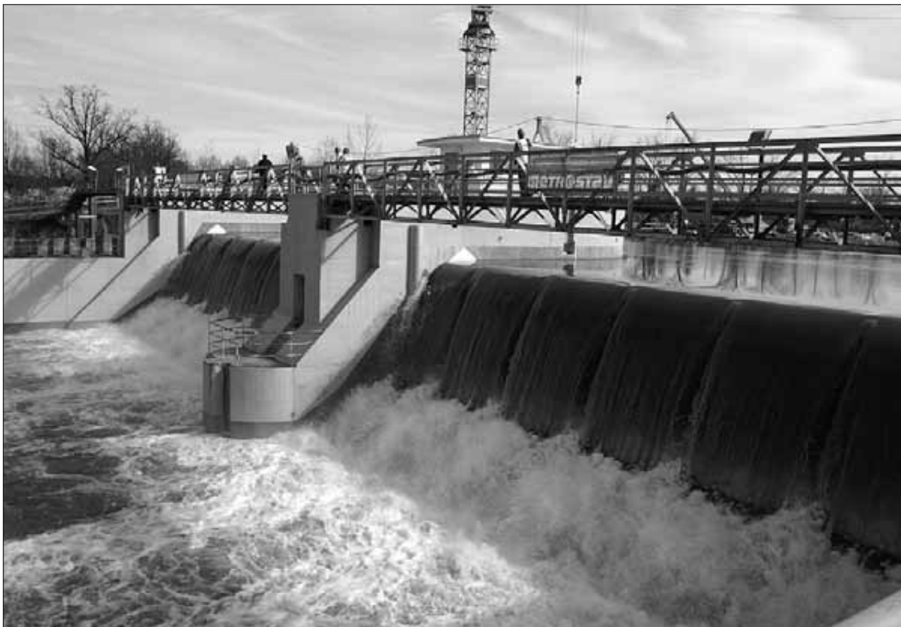
Modernizovaný jez v Českém Vrbném při slavnostním ukončení stavby dne 2. 3. 2010 převáděl zvýšený průtok vody 85 m 3 /s. Generální dodavatel Metrostav a.s.
