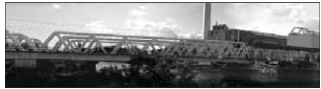
Vizualizace nového železničního mostu v Kolíně, jehož výstavba právě probíhá
