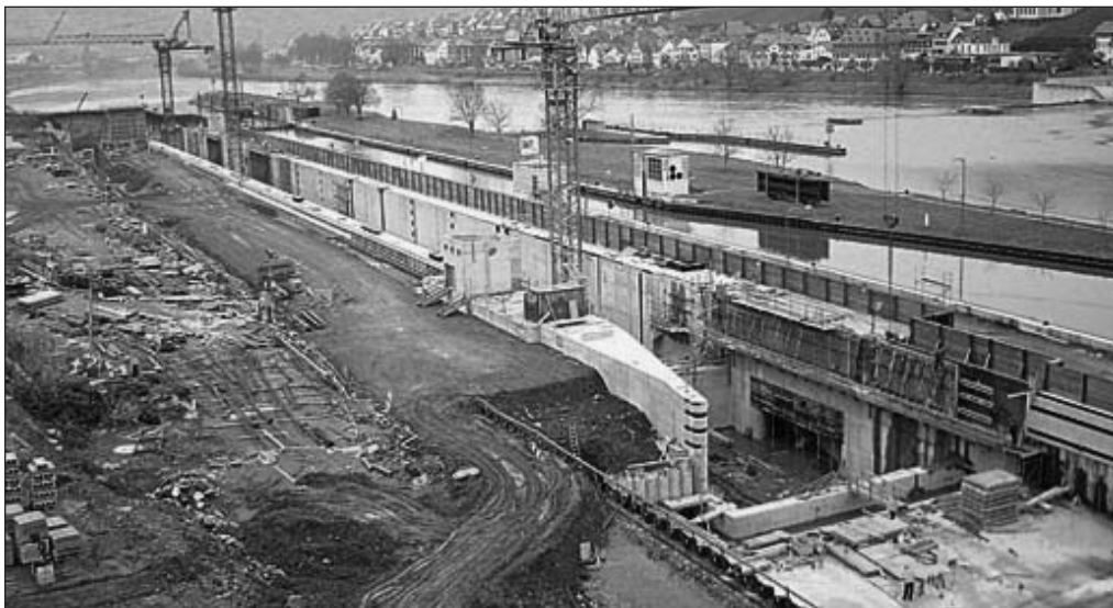
Pohled na novou plavební komoru Zeltingen ještě ve výstavbě, dnes už proplavuje lodě
