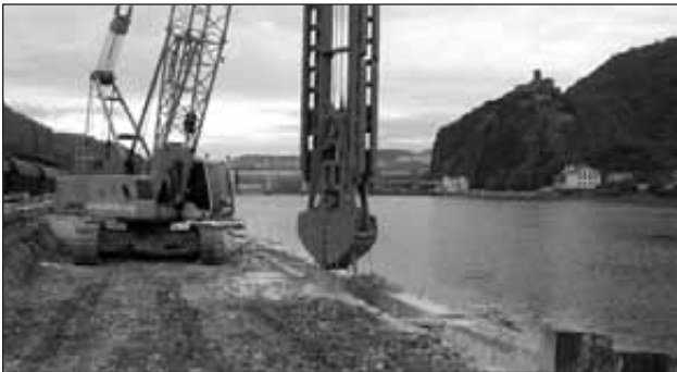
Výstavba přístavní zdi ve veřejném přístavu Ústí nad Labem – Vaňov
