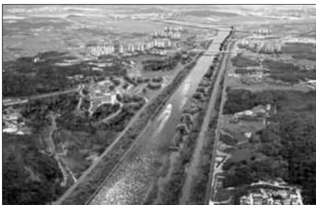
Hlavní část průplavu Gyeong-In, pohled směrem na Soul
