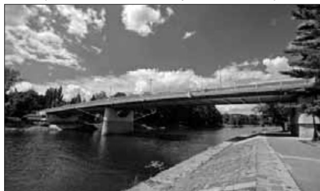
Nový silniční most přes Labe v Poděbradech s podjezdnou výškou 7 metrů.
