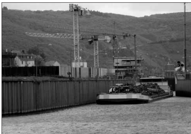
Stavba druhé plavební komory Fankel na Mosele
