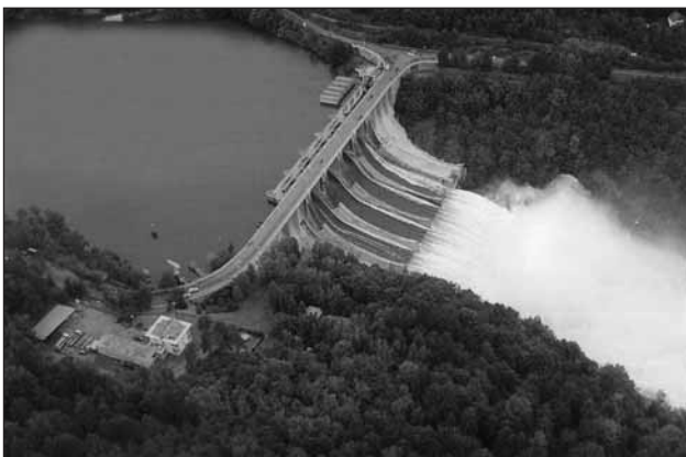
Přelévaná vodní elektrárna na VD Slapy byla v plném bezporuchovém provozu po celou dobu katastrofální povodně na Vltavě v roce 2002.
