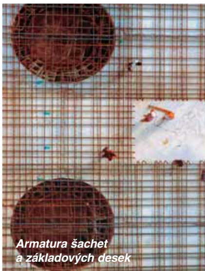
Kotevní šachty pilířů, průměru 5 m, hloubky 12-18 m
