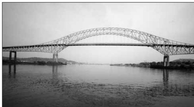
Most přes Panamský průplav byl postaven dle návrhu G. Eiffela
