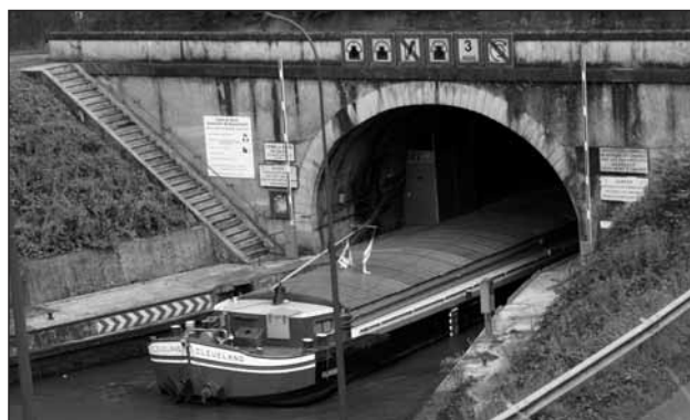
Portál průplavního tunelu Ruyalcourt
