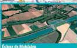
Ecluse de Molvaux
