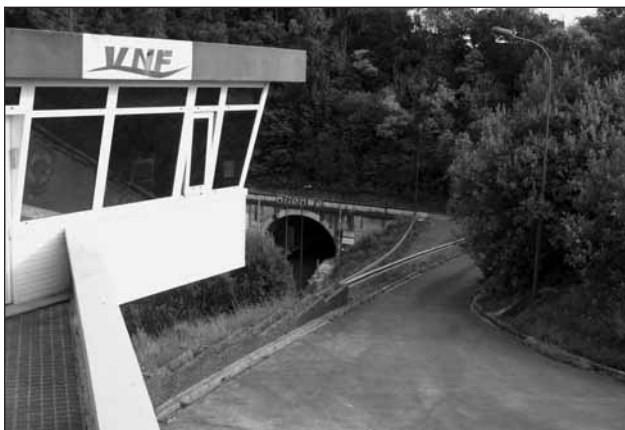
Velín průplavního tunelu Ruyalcourt
