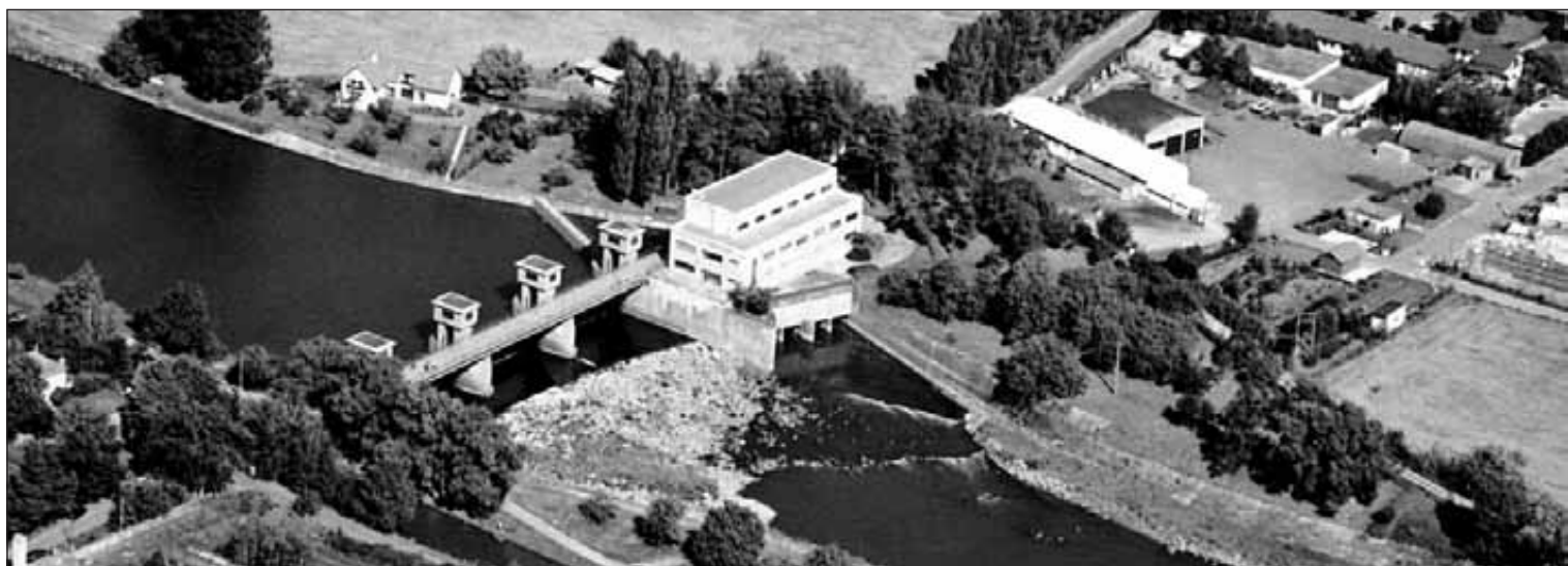
Vodní dílo u Spytihněvi na řece Moravě s vodní elektrárnou vytváří vhodnou zadrž pro vedení vodního koridoru D-O-L. Tato zadrž je součástí Baťova průplavu.
