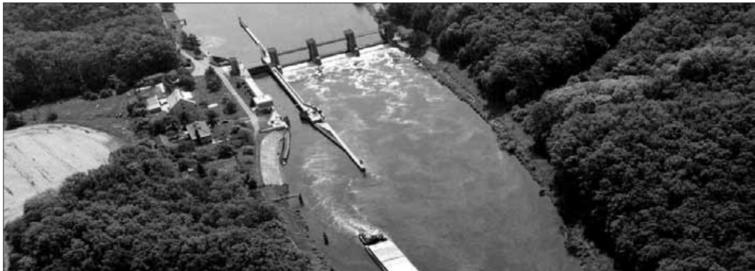
Výstavba zdymadla Velký Osek na Labi byla zahájena roku 1940. Během války však postupovala velmi pomalu, takže k jejímu dokončení došlo až v roce 1952.
