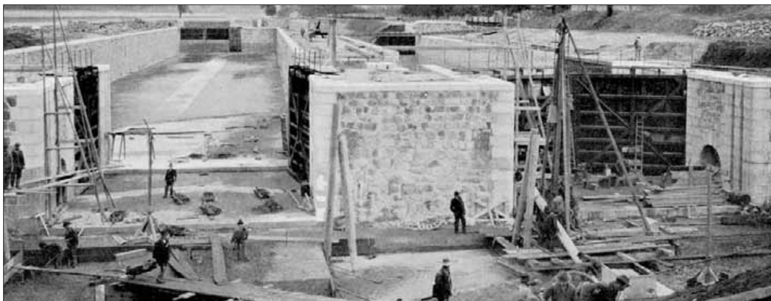
Téměř dokončené plavební komory v Dolních Bejkovicích v roce 1905.
