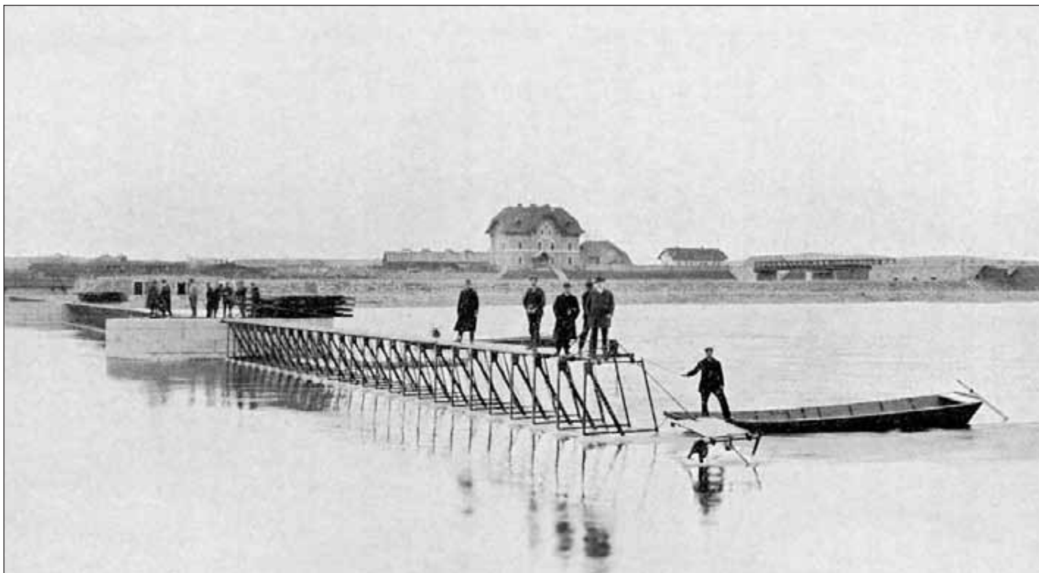
Vyhražování a sklápění hradlového jezu v Dolních Beřkovicích na Labi (1908).
