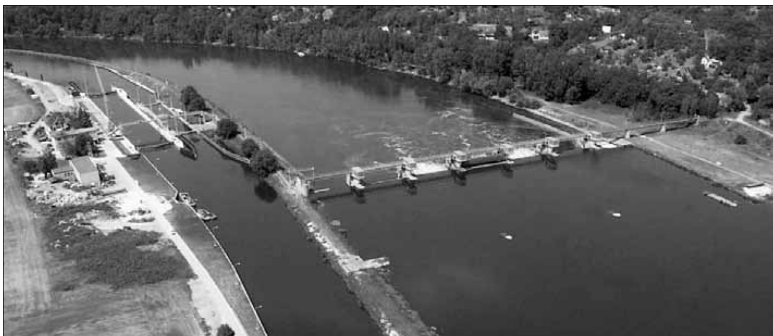
Za náhradu starého jezu ve Štětí moderním segmentovým jezem v roce 1970 vděčí vodní doprava tepelné elektrárně Mělník. Bez spolehlivého jezu, který může udržovat hladinu celý rok, by pro tuto elektrárnu nebylo možno zajistit odběr chladicí vody.
